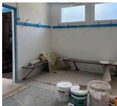
Rénovation des vestiaires du stade de foot. Les travaux avoisinent les 20 000€ TTC
