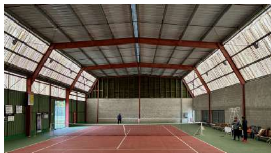
Court de tennis couvert : remplacement en février des translucides devenus opaques.
