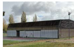
Court de tennis couvert : remplacement en février des translucides devenus opaques.
