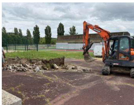
Piscine (suppression d'un muret fissuré et réaménagement en pente douce engazonnée)
